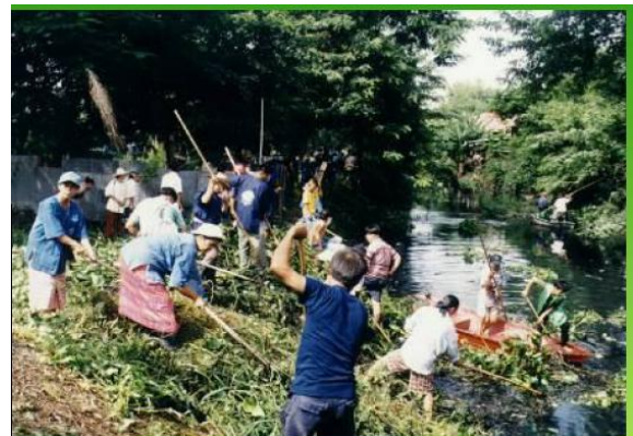
Les membres d'une communauté nettoient un canal avant de commencer un projet de logement, (2010)
